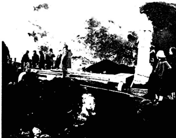
Fig. 19. Et lille geotermisk varme anlæg på den nye lavastrøm på Heimaey.
