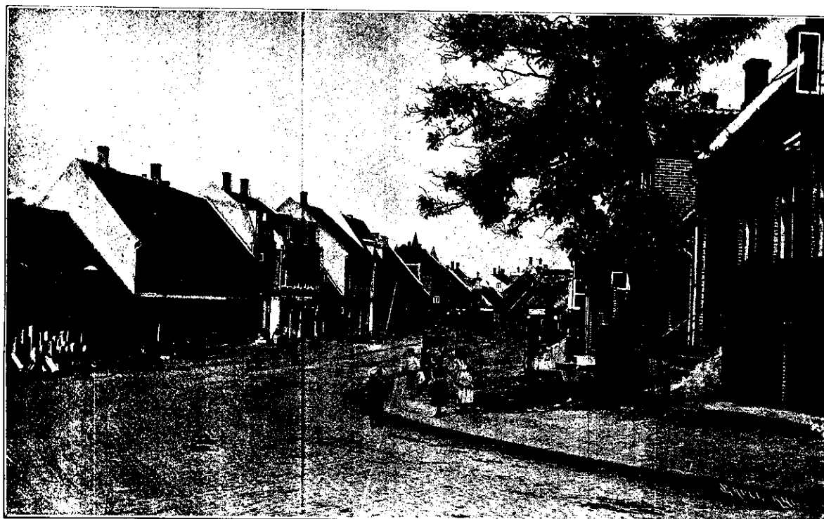
Fra Nedrebyen. Cordilgade.
